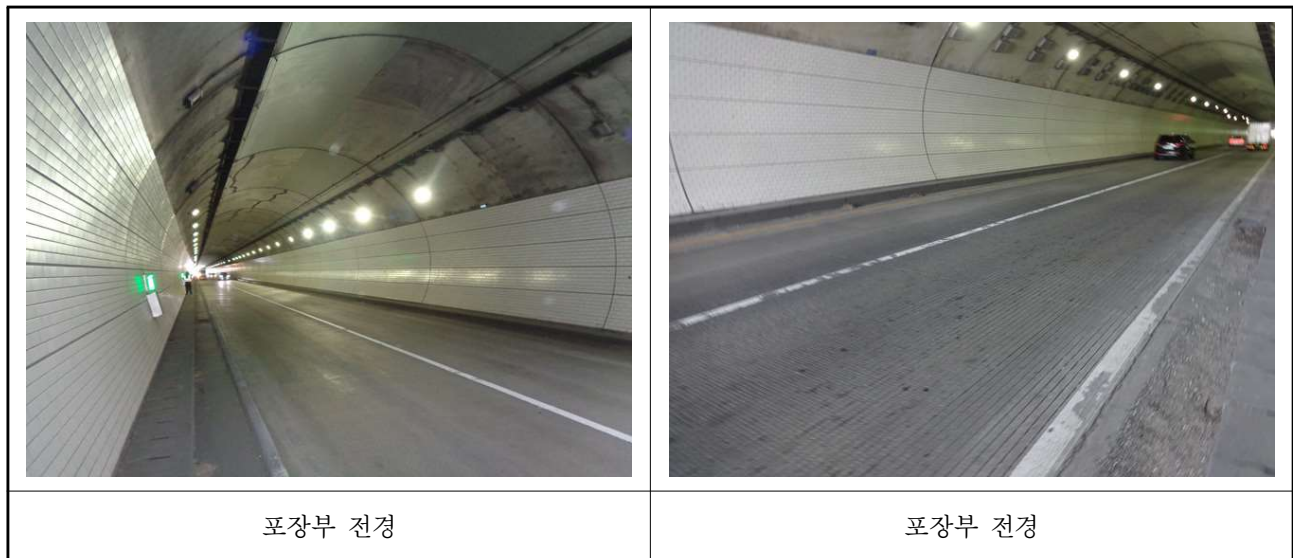
【사진 3.13】 터널 포장부 전경
